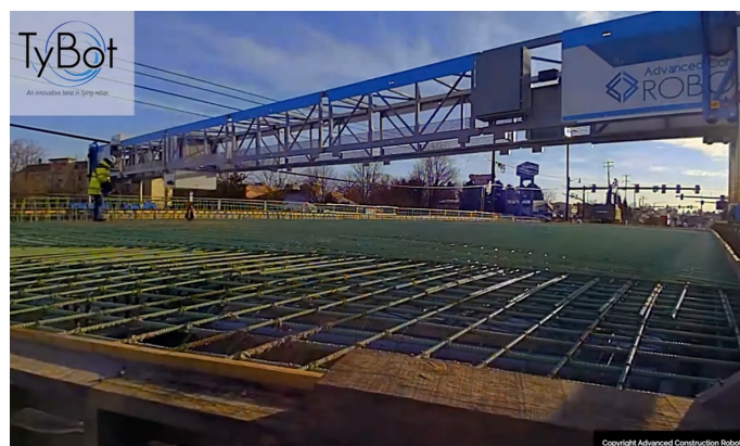
(미국) 철근 결속 로봇 : 컴퓨터 비전 기반 결속 지점 자율 탐색 및 결속
