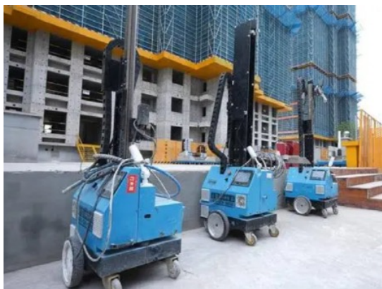
(중국) 리프트형 자동 용접 로봇 : 철골 구조를 따라 이동하며 용접 수행
