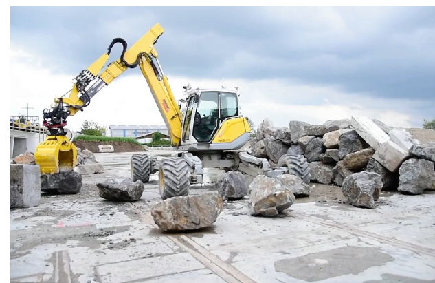
(스위스) 자율 굴삭기(HEAP) : 내장 센서로 주위 환경을 스캔하고 각 돌의 최적 설치 장소를 결정
